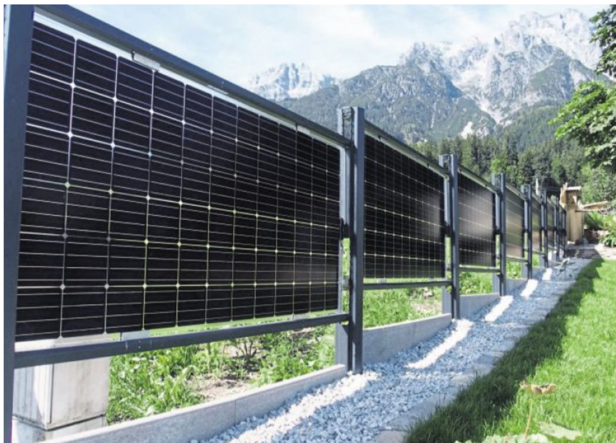
Keine Zukunftsvision, sondern bereits Realität ist – wie hier in Österreich – der „bifaziale Solarzaun“. Bild: Elektrotechnik Leitinger
