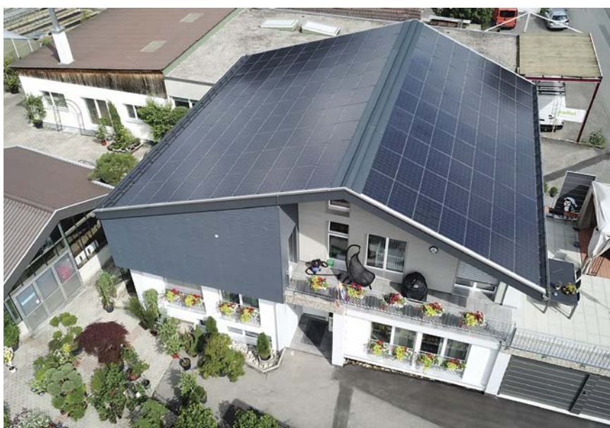
Die 30 Kilowatt leistende Indachanlage versorgt zwei Wohnungen und eine benachbarte kleine Gärtnerei mit Solarstrom
