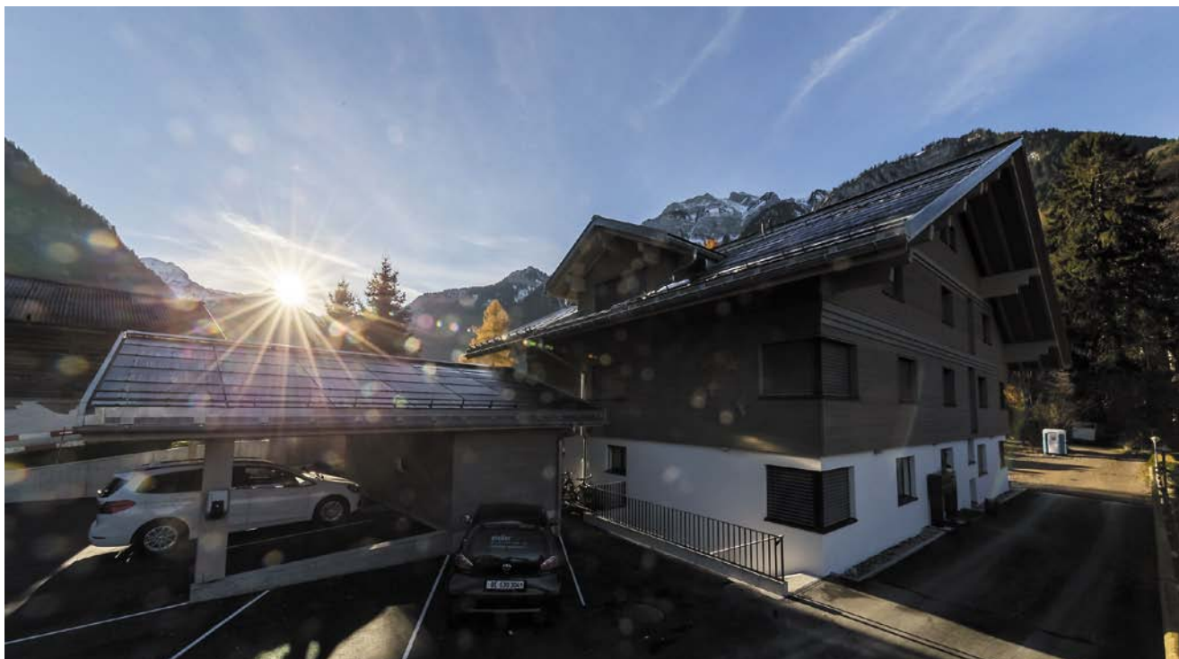
Dieses Mehrfamilienhaus im Schweizer Kanton Bern wird durch Photovoltaik zu einem Plusenergiehaus
