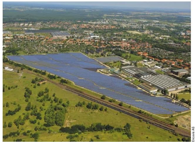
Noch viel Platz auf den Dächern: Brandenburg/Havel (im Vordergrund eine 18,7-Megawatt-Freiflächenanlage der Encavis AG)
