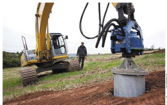
Öffnungsklausel: Hessen weist pro Jahr rund 50 Hektar zusätzlich als potenzielle Photovoltaikstandorte aus (Foto: Montage von Fundamenten für Nachführsysteme in Edertal)
