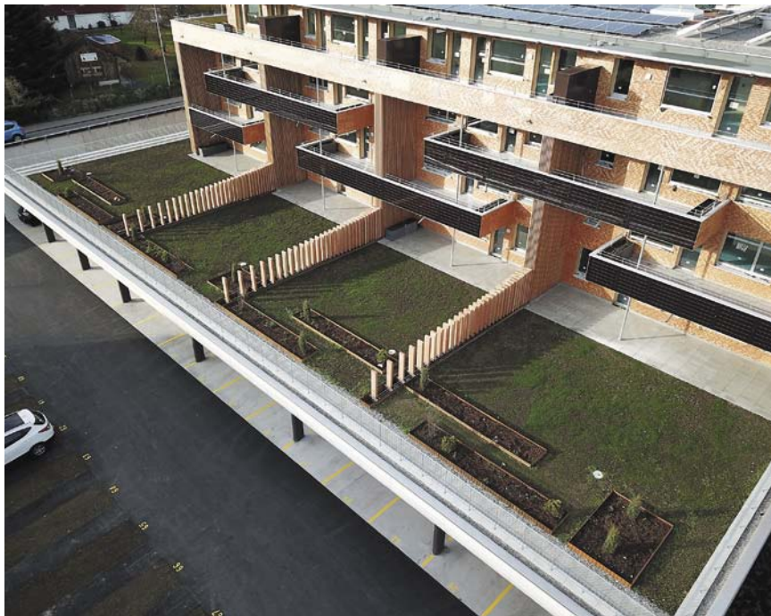
Die Unterkonstruktionen für die Module an den Balkonen sind maßgefertigt
