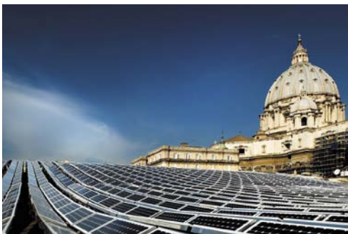
Hohe Symbolkraft: Die Photovoltaikanlage am Petersdom nahm vor zehn Jahren ihren Betrieb auf
