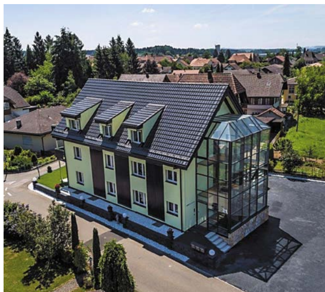
Die 6,2 Kilowatt leistende Fassadenanlage wurde in drei Streifen senkrecht installiert
