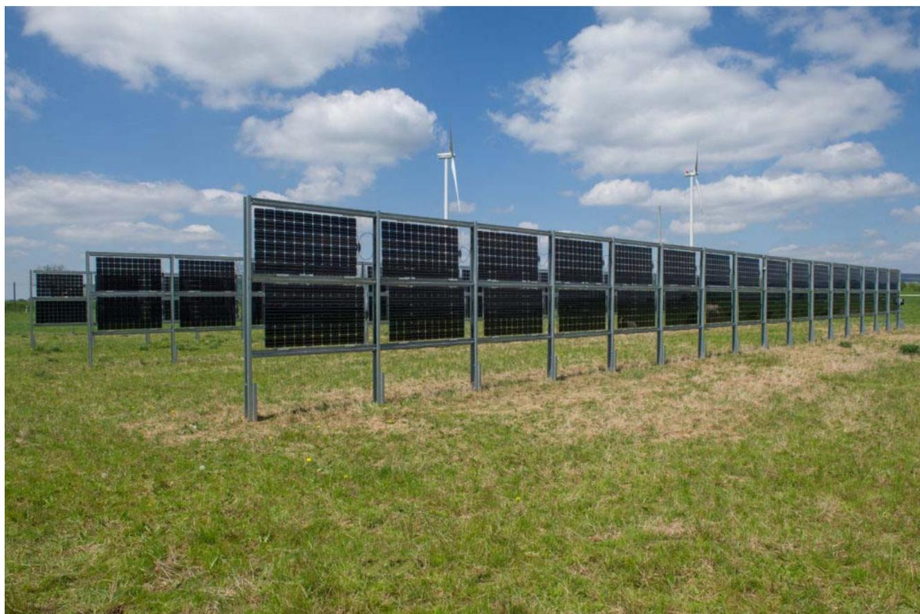
Pilotanlage in Losheim am See (Saarland) mit senkrecht aufgeständerten Solarmodulen und einer Leistung von 28 Kilowattpeak.
