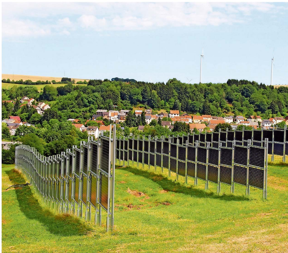
Die Anlage mit ihrer senkrechten Ausrichtung ist europaweit ein Pilotprojekt – sie entsteht derzeit in Dirmingen.
