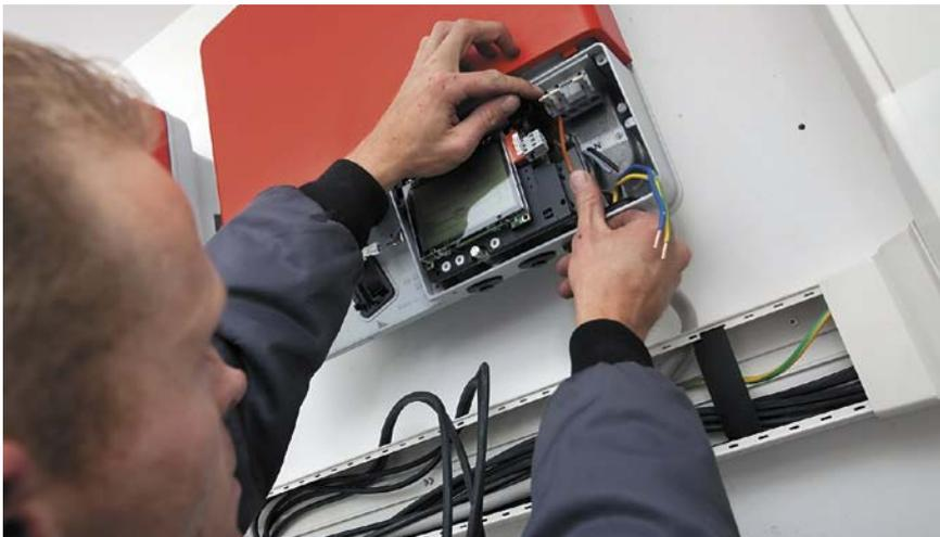
**Grenzwertlücke:** Auf der Wechselstromseite von Photovoltaikanlagen gelangen Störsignale zum Einspeisezähler, die bis vor einigen Jahren in Normen und Prüfverfahren nicht berücksichtigt wurden
