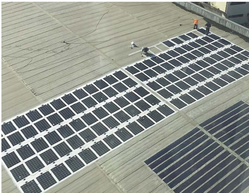
Anlage mit M210-Modulen von OC3: Die Befestigung erfolgt durch Schweißen am umlaufenden, etwa zehn Zentimeter breiten weißen Rand.
