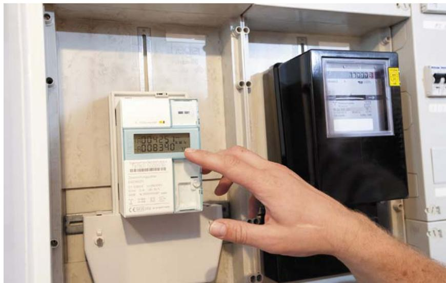
**Austausch vorgeschrieben: Elektronische Zähler (links; das gezeigte Gerät war übrigens nicht auf dem Prüfstand der Uni Twente) sollen die bekannten Ferraris-Geräte (rechts) in den nächsten Jahren vollständig ersetzen**
