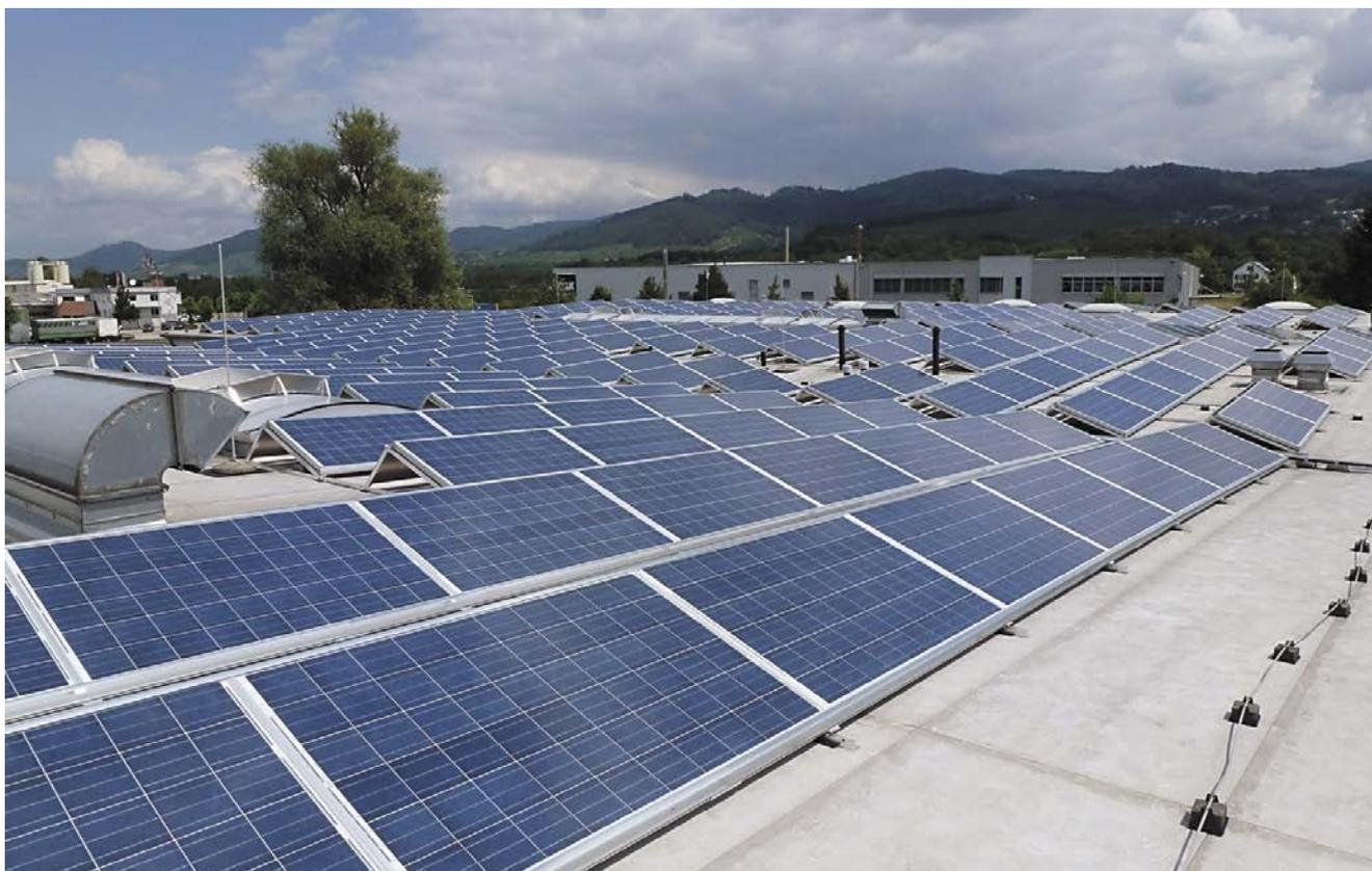
Dachflächen ausreichend für mehrere hundert Kilowatt Anlagenleistung gibt es durchaus: Hier eine 650-Kilowatt-Anlage in Hochstadt, installiert von der Solar-Info-Zentrum SIZ GmbH.
